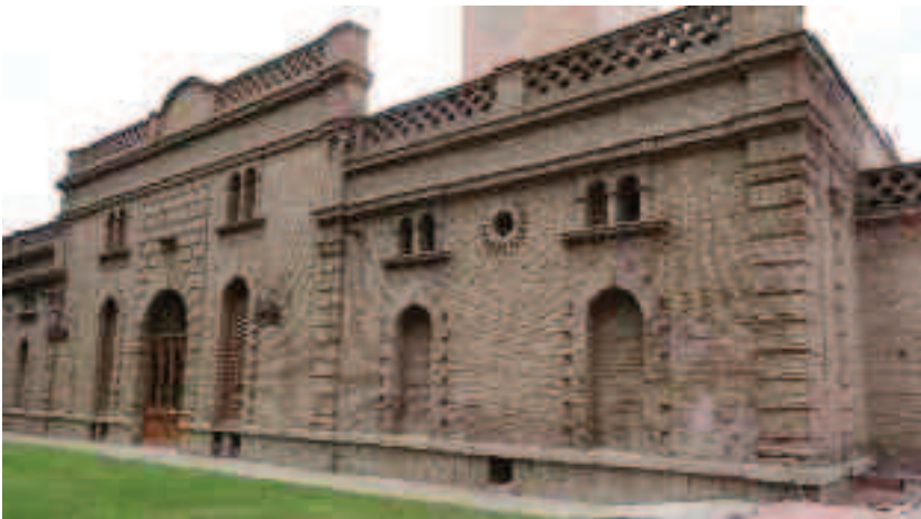
Weingut Weinert in Mendoza (Argentinien): Das koloniale Backsteingebäude stammt aus der Mitte des 19. Jahrhunderts.
